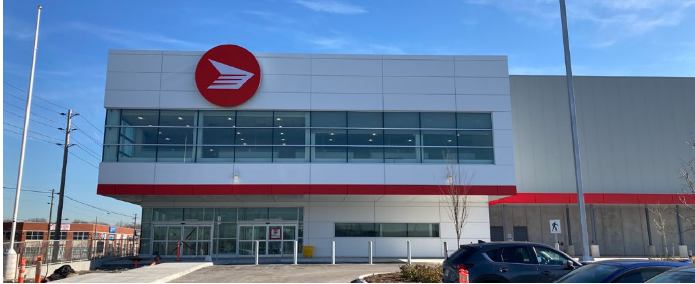
Centre de traitement Albert-Jackson : première installation carboneutre de Postes Canada
